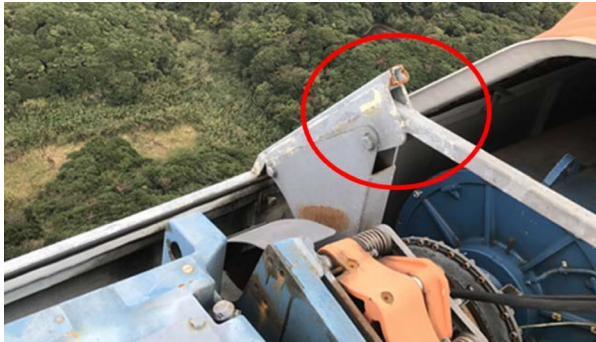
図 17 フレーム破断箇所（ヒンジ側，根占 8 号）
