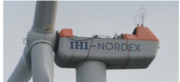
図 3 風車の被害状況
