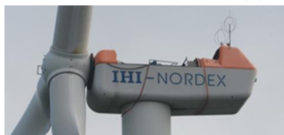
図3 風車の被害状況
