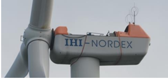
図 3 風車の被害状況
